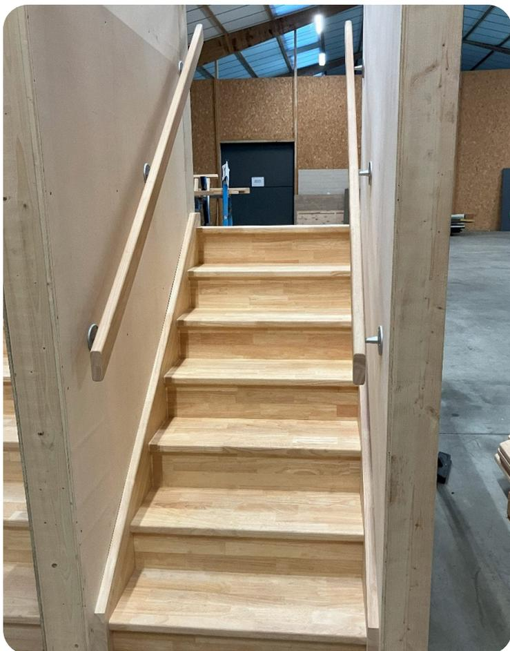
**Option 5 :** Pose d'un escalier droit enclouonné avec mains courantes à scellement.
