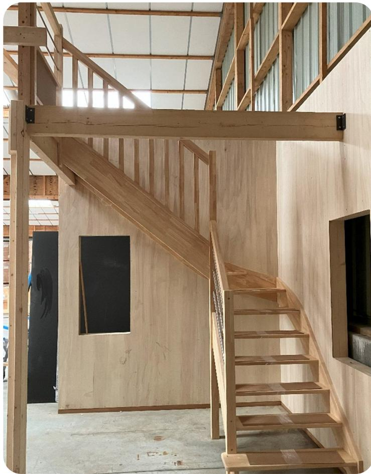
**Option 3** : Pose d'un escalier tournant milieu en hêtre LCA sans contremarches, GCR avec lisses et balustres et GCE avec panneau bois.
