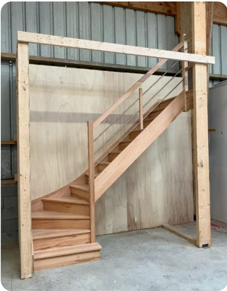
**Option 1 :** Pose d'un escalier 1/4 tournant bas, gamme élémentaire en hêtre rouge avec contremarches, GCR avec lisses et GCE avec panneau bois.
