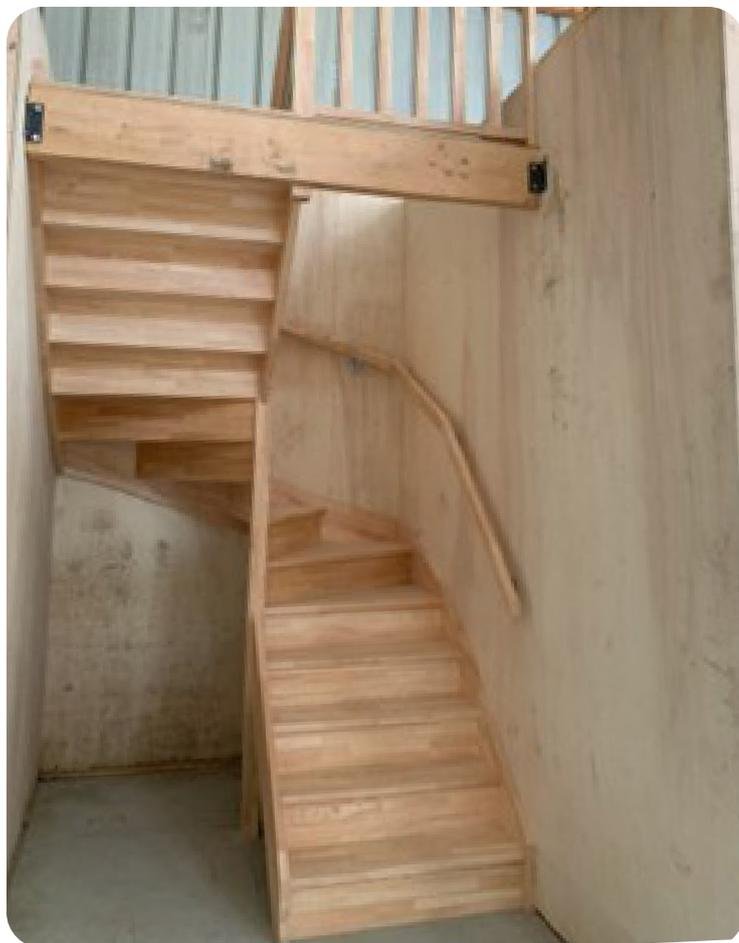
**Option 7 :** Pose d'un escalier 2/4 tournant avec contremarches et mains courantes à scellement.
