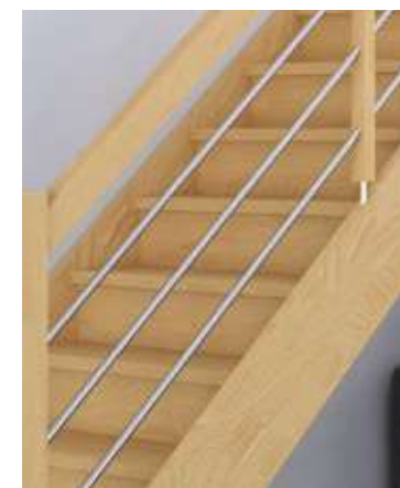
↑ Lisses en aluminium anodisé mat Ø18mm
